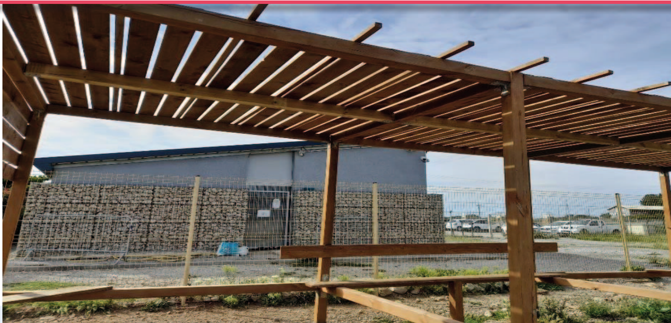
Couverture des abris des enclos
